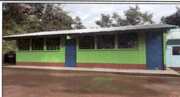
Foto 02: pintura en muros exteriores en módulo de aulas
