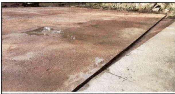
Foto 05: reparación de plancha de concreto de patio 10 centímetros de grosor
