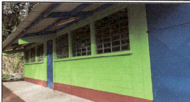
Foto 01: pintura en muros exteriores en módulo de aulas
